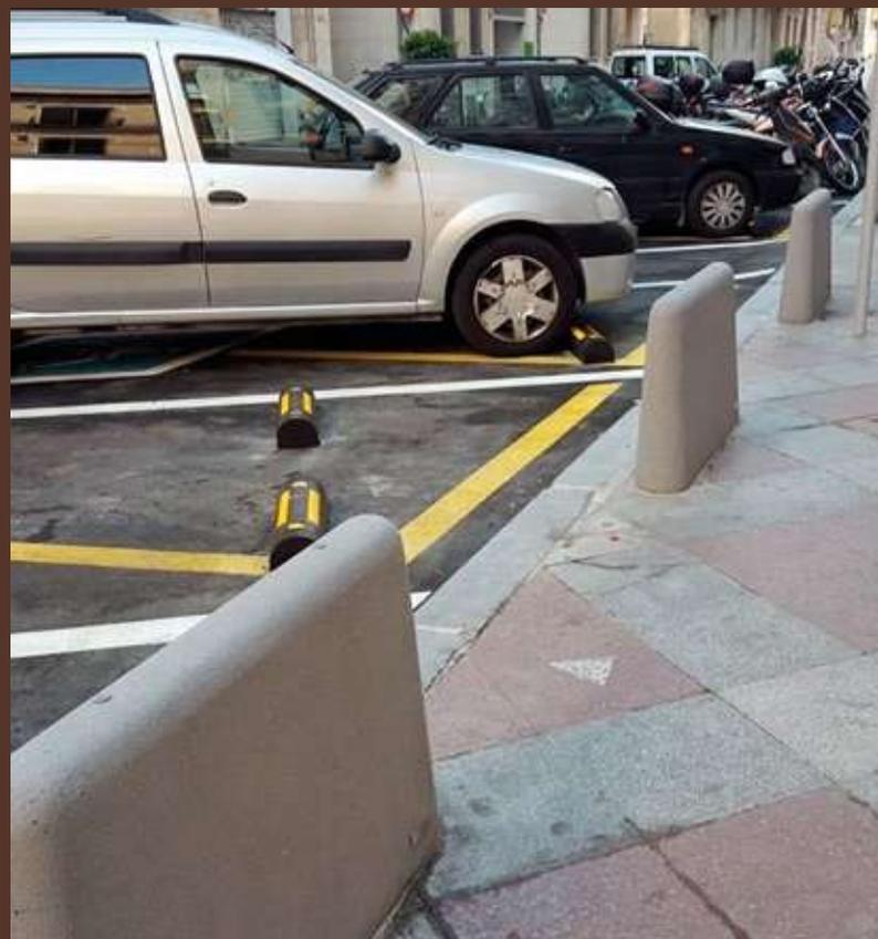
**MATERIAL:** Hormigón prefabricado hidrofugado con armadura de acero.
